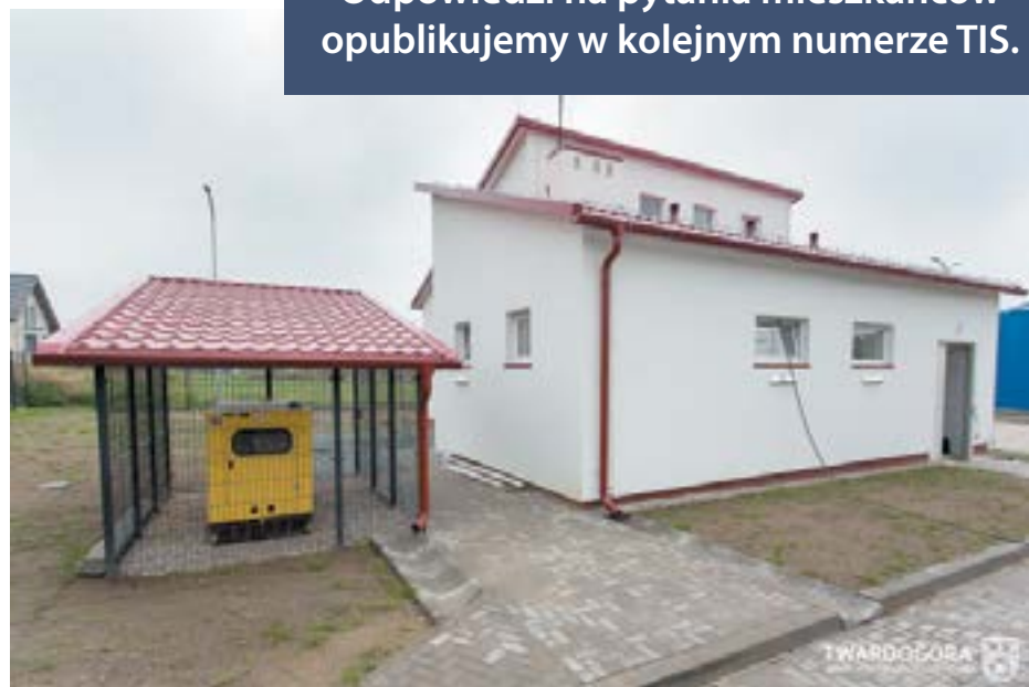
SUW w Grabownie Wielkim na ukończeniu
