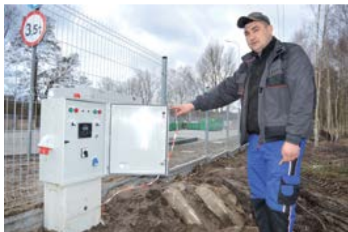
Ostatnią fazą, która pozwoli Związkowi na otwarcie punktu, była realizacja budowy sieci wodociągowej
